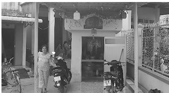
Miếu Thành Hoàng (đường Chùa, khu phố Lãng 1) và miếu Thành Hoàng (đường Đáy Chay, khu phố Lãng 1). Ảnh: Nguyễn Thanh Lợi, 2023
