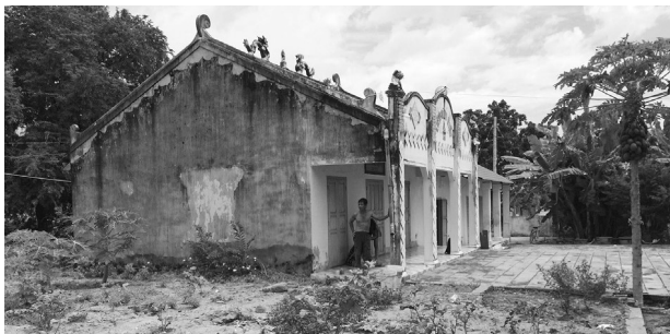
Liêm Công Hiệp Tự - 1955, bên cạnh là một nền móng rất lớn
